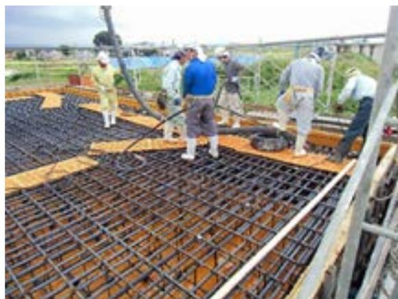
**Рисунок 7. Укладка и уплотнение бетона**
